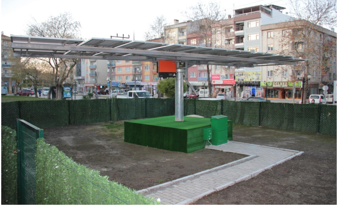
Şekil 3.6: 4 kilovatlık çift eksenli ongrid fotovoltaik güneş enerjisi santrali (Gürsu Belediyesi, 05.05.2015).
