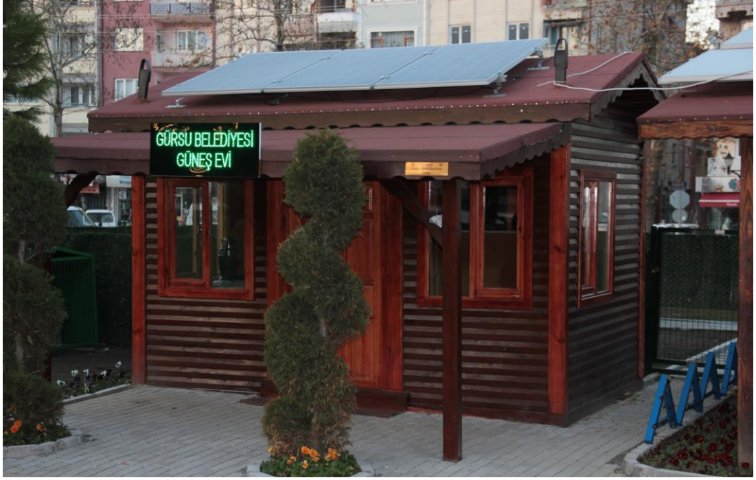
Şekil 3.7: 3 kilovatlık mobil güneş evi (Gürsu Belediyesi, 05.05.2015).
